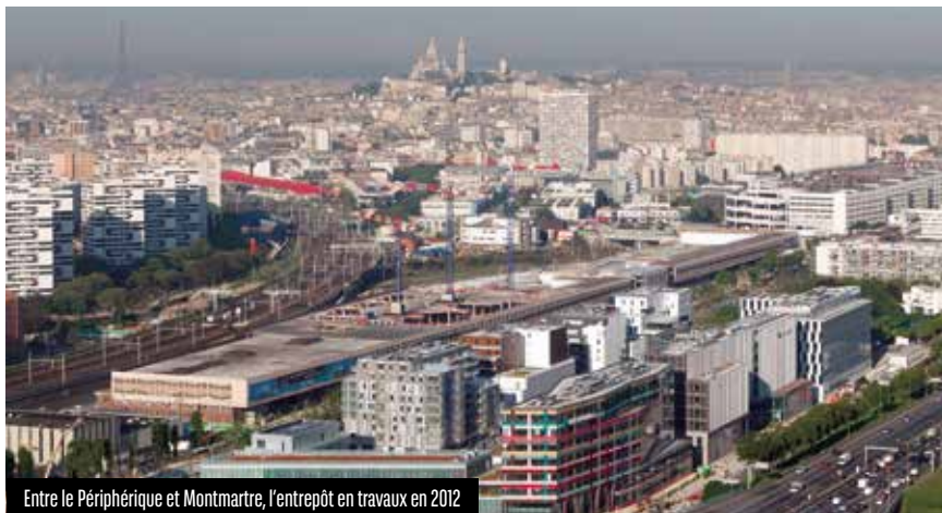
Entre le Périphérique et Montmartre, l'entrepôt en travaux en 2012
