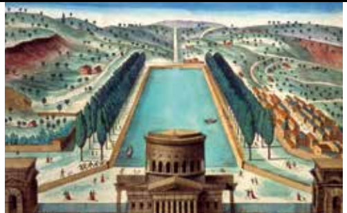
Le bassin de La Villette vers 1810
