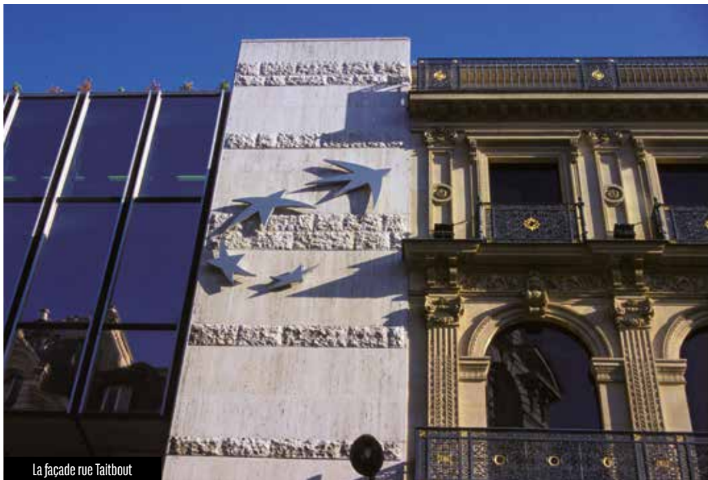
La façade rue Taitbout
